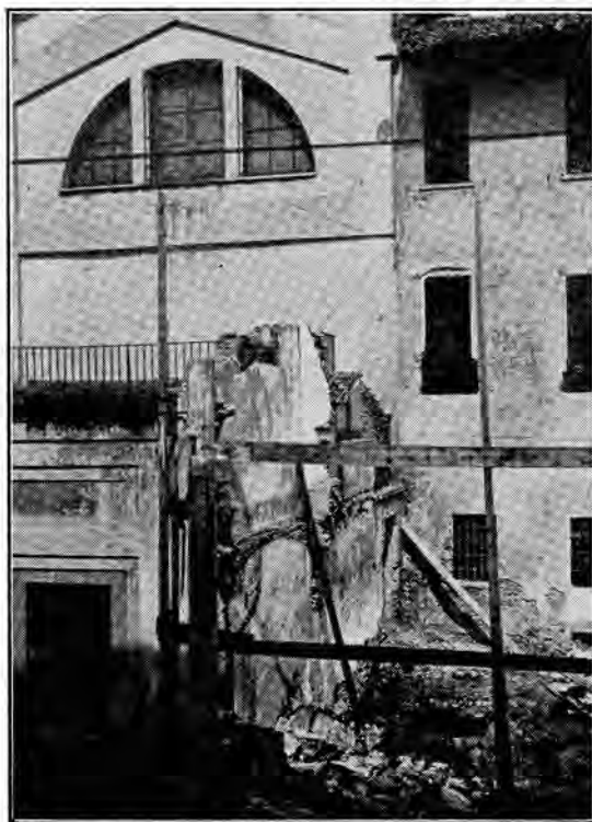
L'abside della Chiesa ed il vecchio fabbricato in demolizione
