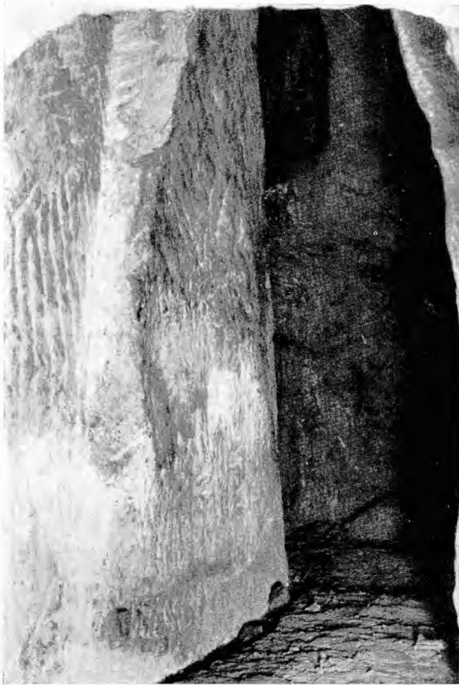
L'uniforme lavoro degli scalpellatori sulle pareti delle gallerie
