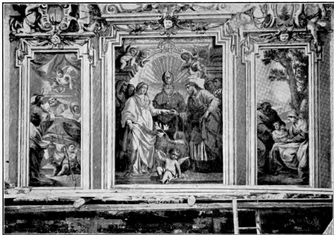
Gli affreschi puntellati durante i lavori di rifacimento del muro
