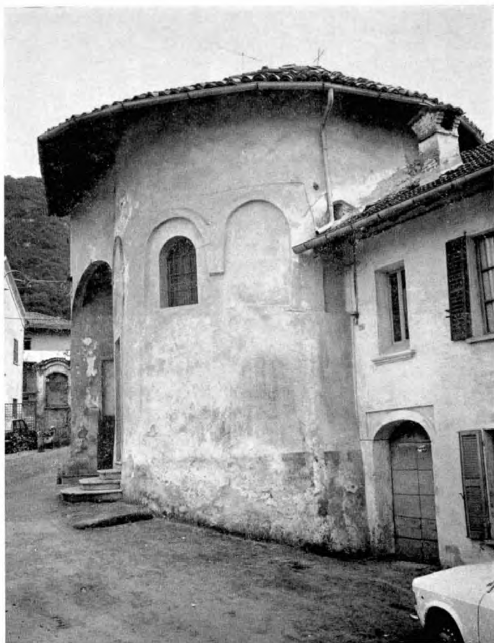
Fig. 1 - Vista esterna del battistero da nord-ovest. La finestra a sinistra è di apertura ottocentesca mentre una delle monofore originarie si intravede appena sopra il tetto dell'annessa casa parrocchiale.
