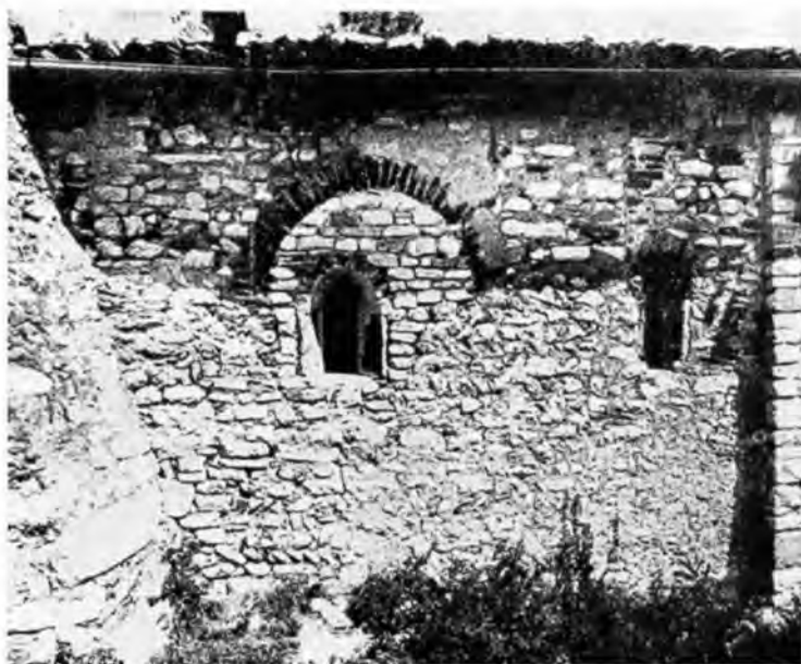
Fig. 2 - Lato sud della chiesa. Si notino le due monofore: quella di sinistra, ricostruita, è inscritta nell'arco della finestra aperta nel '500.
