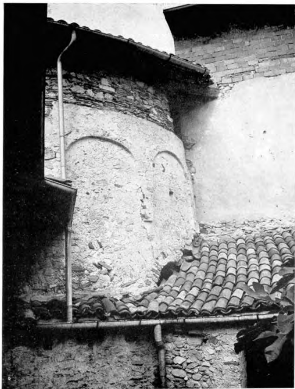
Fig. 2 - Il battistero da meridione. Qui sono meglio conservate le archeggiature. E' evidente il livello primitivo della copertura, poi sovralzata. Si scorge anche la centinatura della porta sud.
