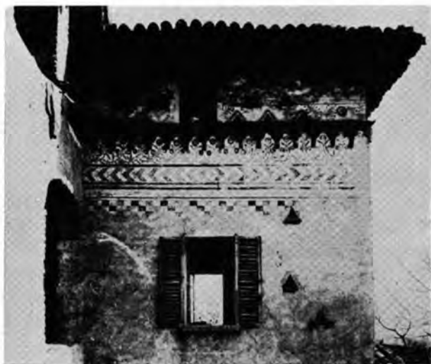
Fig. 19 - Varese, località Bettole, cascina Baroggi. (Si noti la fascia decorativa quattrocentesca simile a quella della figura sottostante).
